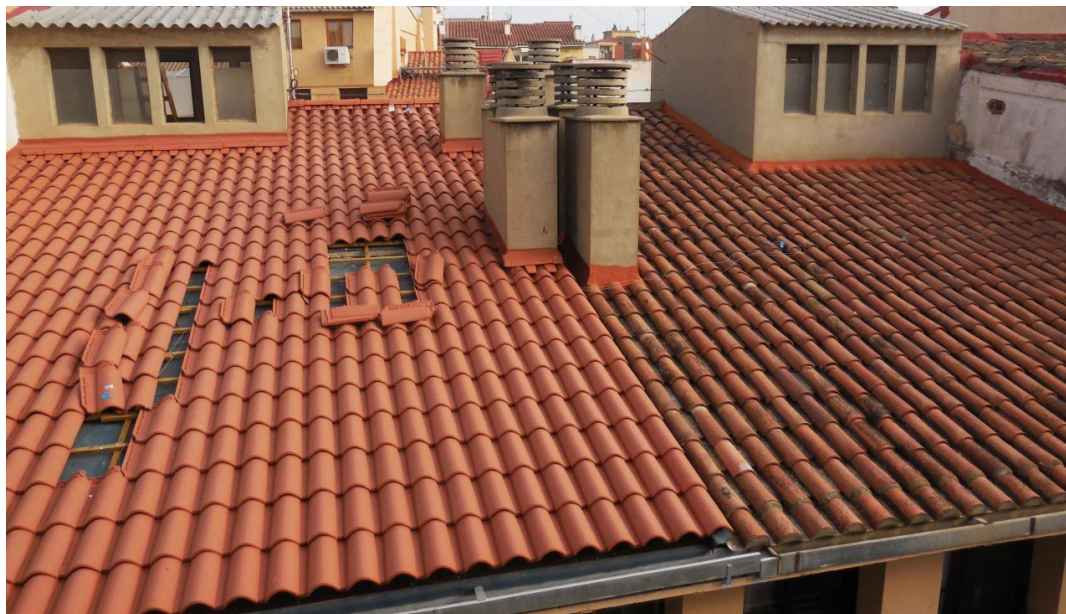
A sinistra, la porzione di tetto con le tegole portoghesi Hertotile; a destra il tetto esistente con le tegole portoghesi tradizionali dell'edificio di Cadelbosco.
